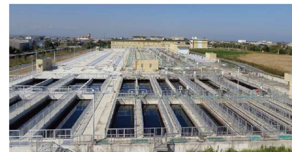
宮川浄化センター(大湊町) 1日最大処理水量 75,600m 3 (全体計画)
