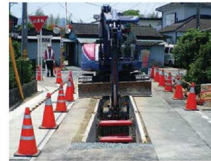
下水道管を埋める穴を掘っている様子
