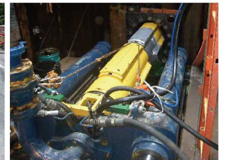
機械で横穴を掘っている様子 (地下深くに下水道管を埋める工事)
