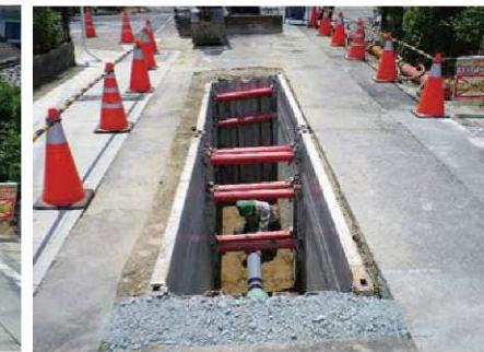
下水道管を埋める様子
